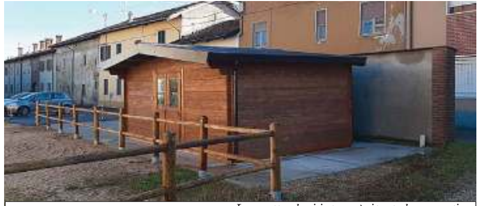
La casetta al cui interno è situata la compostiera
