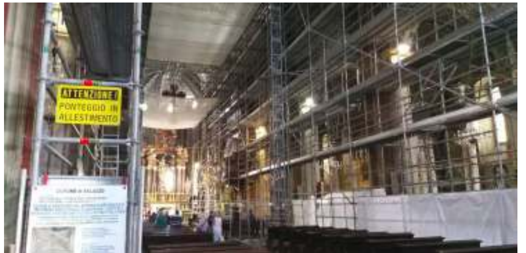
Il grande ponteggio nella navata centrale che permette la celebrazione delle messe anche durante i lavori di restauro
